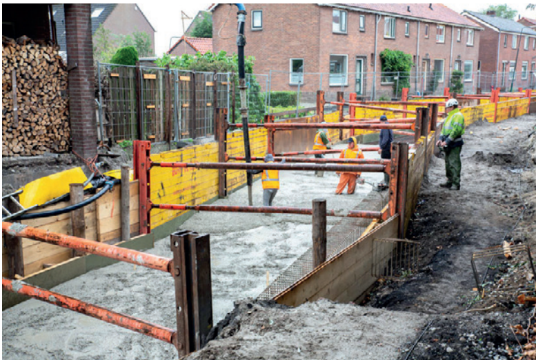
Figuur 2.1 / Aanleg betonfundering in de Pastoor Schuurmanstraat, Kanis. (Bron: gemeente Woerden)
