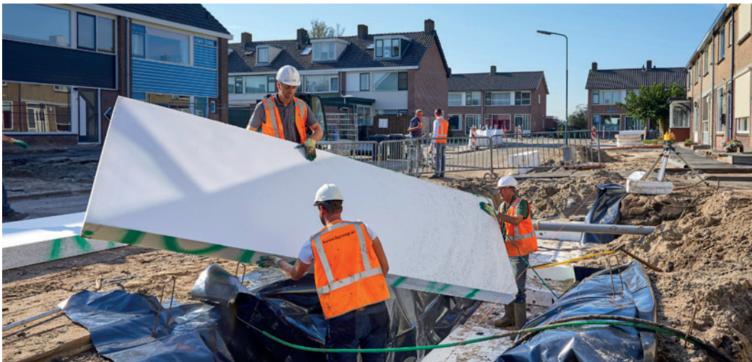
Figuur 3.3 / In de Kanis zijn de noodnetten aangelegd boven op de EPS evenwichtsconstructie in de voortuinen. (Bron: Platform Slappe Bodem/Vincent Basler)
