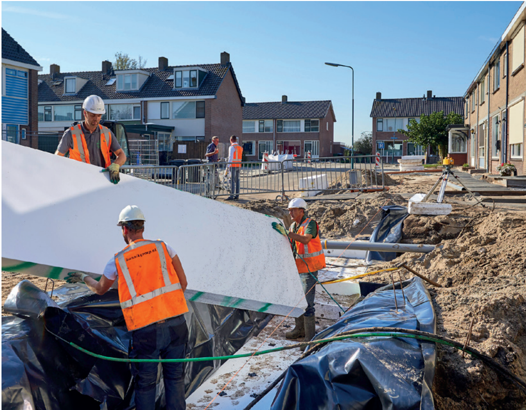
Figuur 2.9 / Reconstructie met EPS. (Bron: Platform Slappe Bodem/Vincent Basler)
