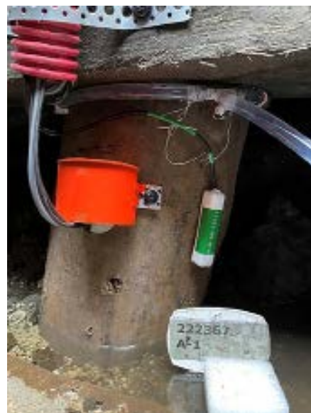
▲ Paal A uit put 1 met sensoren, kraag om conservering aan te brengen en aanwasboorgat voor analyse boorkern.
